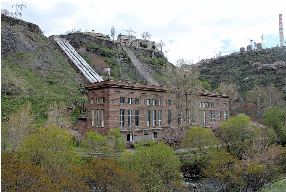
Рисунок 1. Здание Канакерской ГЭС
